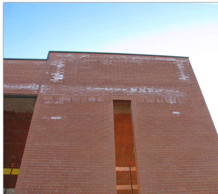
LUCCA, EDIFICIO IN COSTRUZIONE Parete in laterizio faccia a vista
