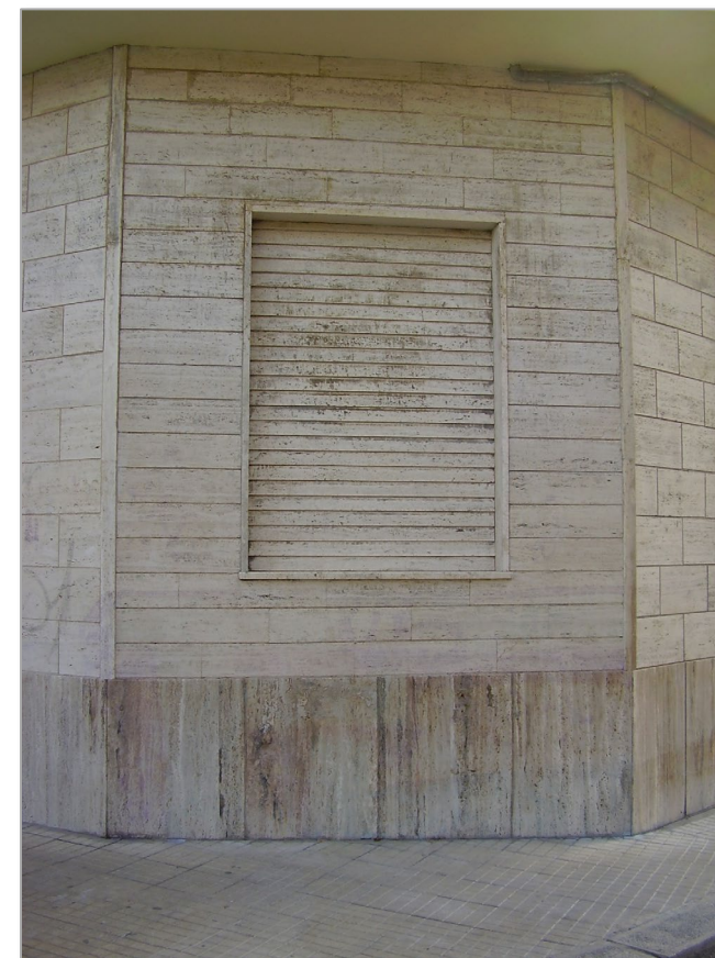
Rimozione con OC12 di croste nere di smog, efflorescenze di natura gessosa (solfatazioni) e graffiti.
