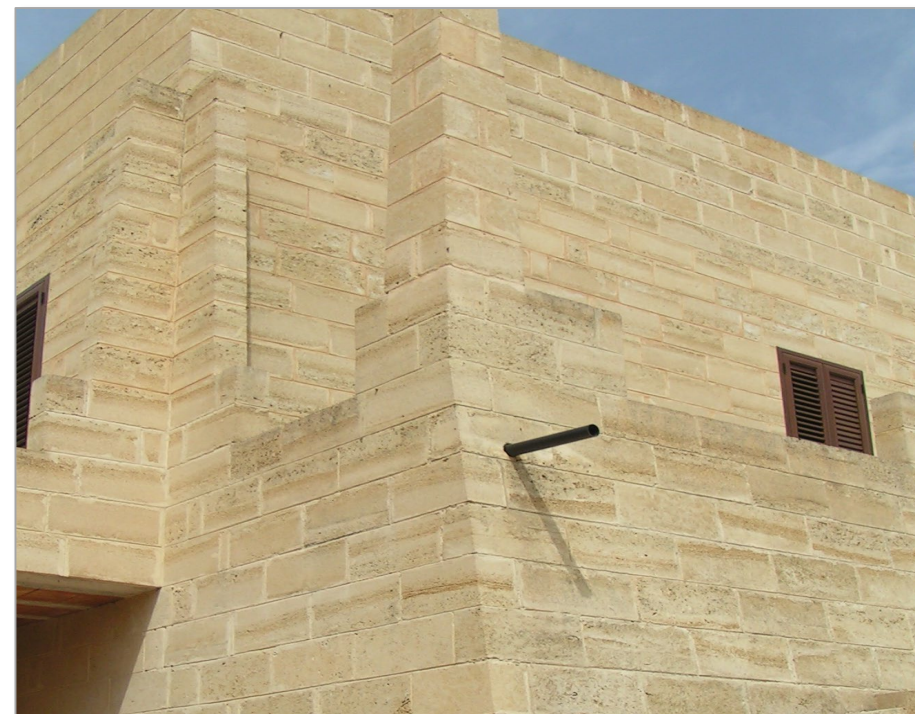
BARI, ABITAZIONE PRIVATA Strutture murarie in pietra leccese
