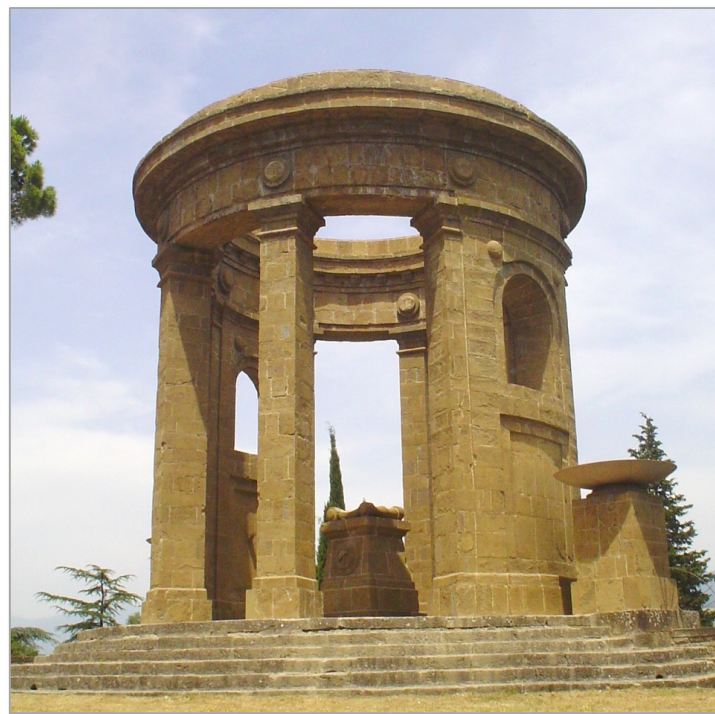
AREZZO, MONUMENTO AI CADUTI Struttura in pietra
