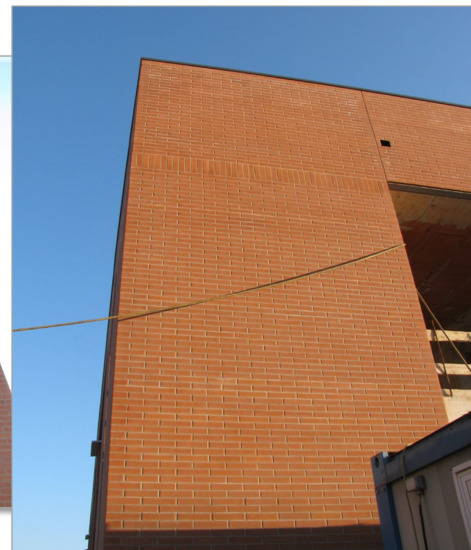
Rimozione con 13H3 di efflorescenze saline e residui di legante cementizio utilizzato per la posa in opera e la stuccatura dei mattoni.
